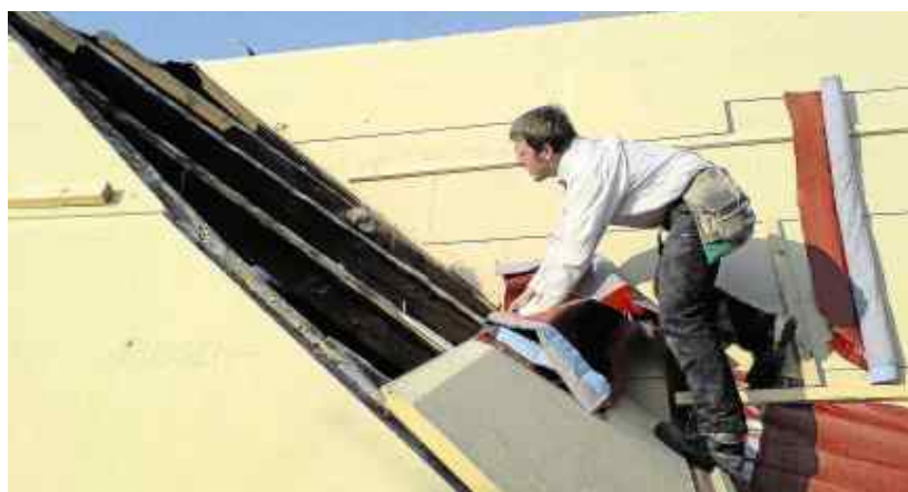
Assez peu répandu en France, le Sarking doit être réalisé par des professionnels.
